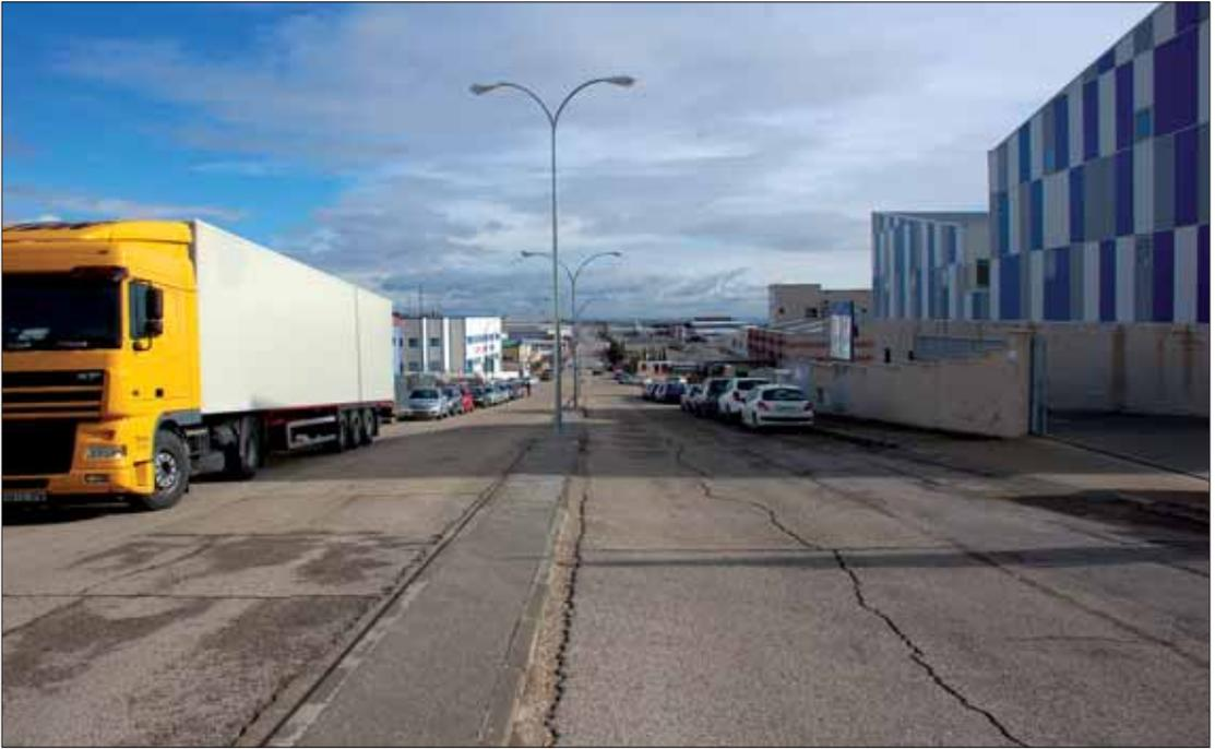
En cuanto a las calzadas, se llevará a cabo el fresado de toda la capa de rodadura con carácter previo a la extensión de dos capas de aglomerado asfáltico en caliente, a modo de regularización la primera y de refuerzo e impermeabilización del firme la segunda.
