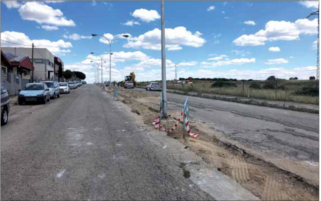
lo concerniente a los pavimentos de aceras y calzadas como a la red de alumbrado público, la cual cuenta con luminarias que no satisfacen los requerimientos del Reglamento de Eficiencia Energética al estar equipadas con lámparas de vapor de sodio a alta presión, sin regulación de flujo.
