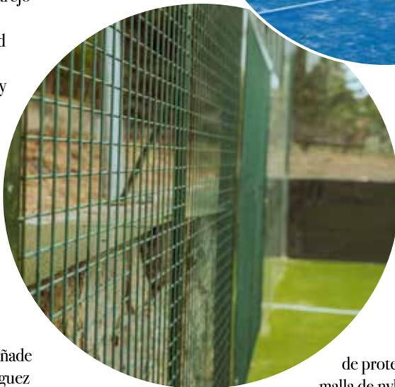
de protección de malla de nylon en la parte superior de los fondos y lateral, renovación del vallado perimetral que pasa a ser de red metálica galvanizada y sobre los vidrios que conforman el cerramiento de la pista, se han incluido vinilos disuasorios para evitar el impacto de aves.
